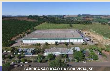
FABRICA SÃO JOÃO DA BOA VISTA, SP
