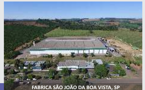
FABRICA SÃO JOÃO DA BOA VISTA, SP
